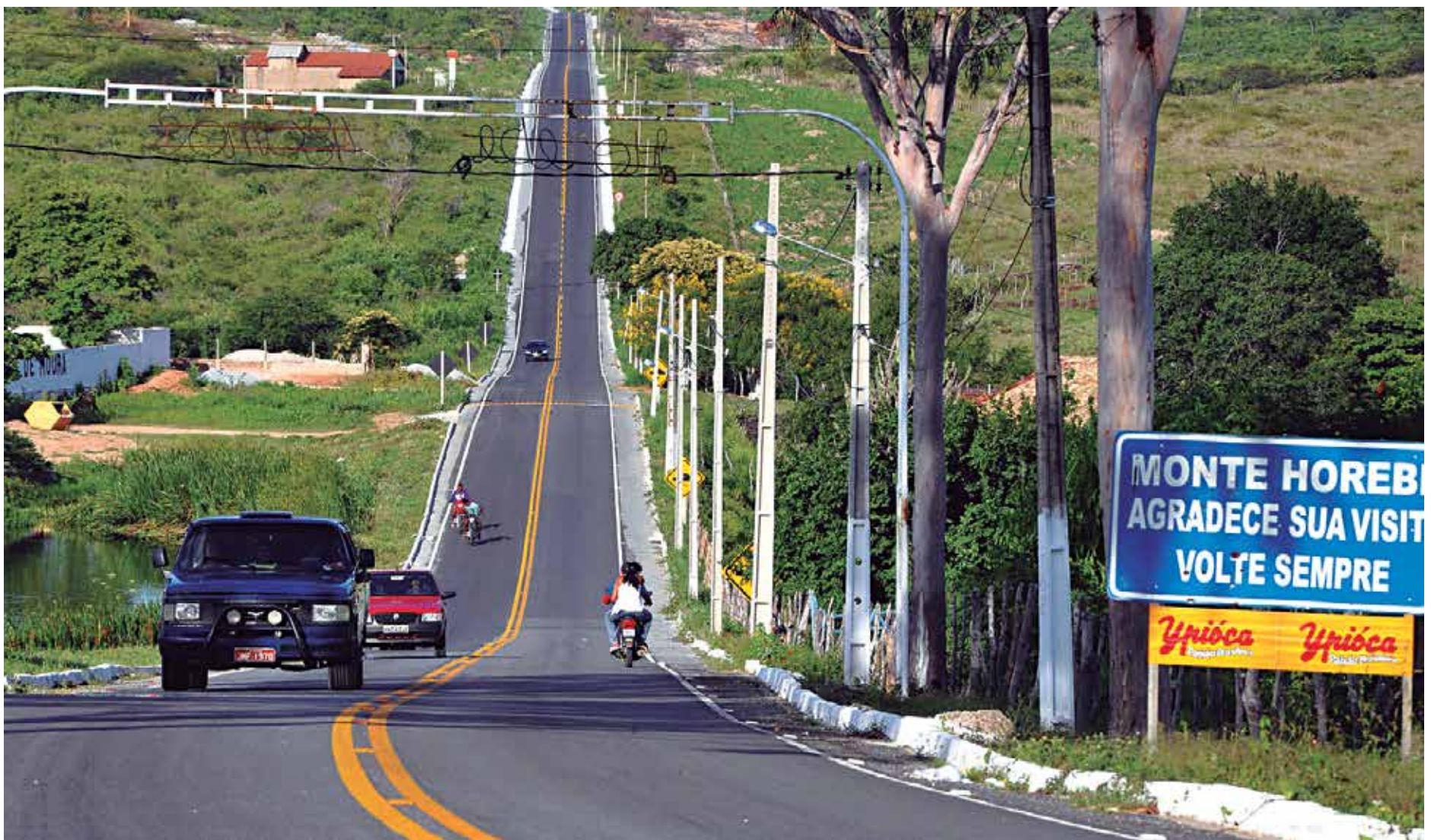
Os investimentos em construção e recuperação de estradas na Paraíba têm garantido acesso de qualidade à população e retirado municípios do isolamento
